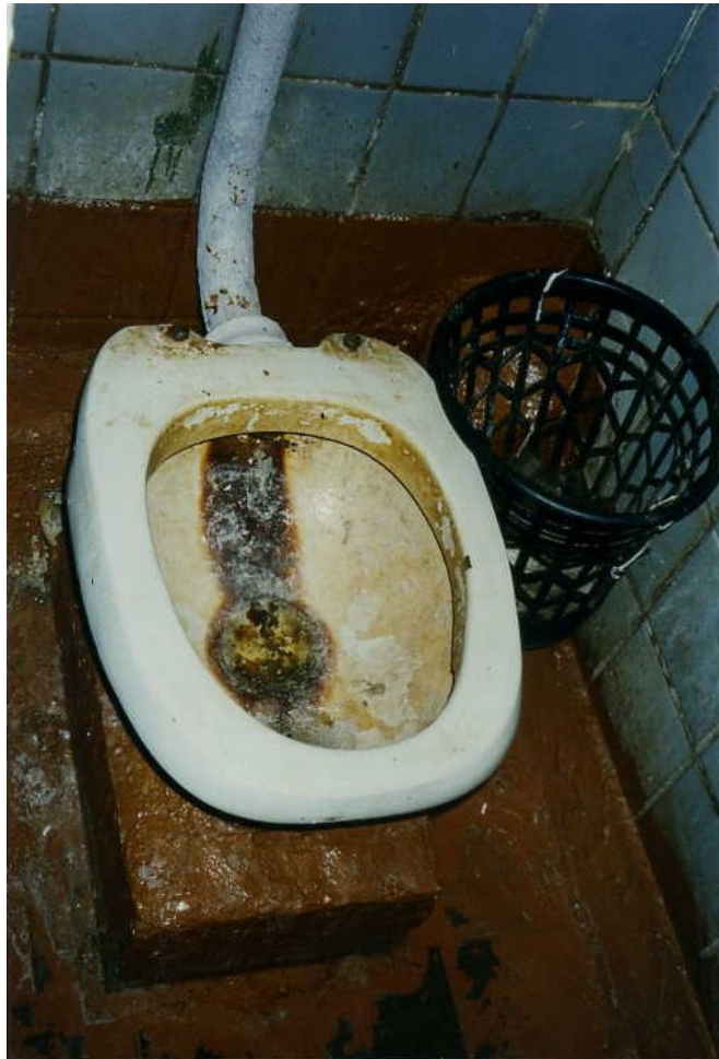
Une des toilettes de « Perce-Neige » avant leur remplacement par l'association.
