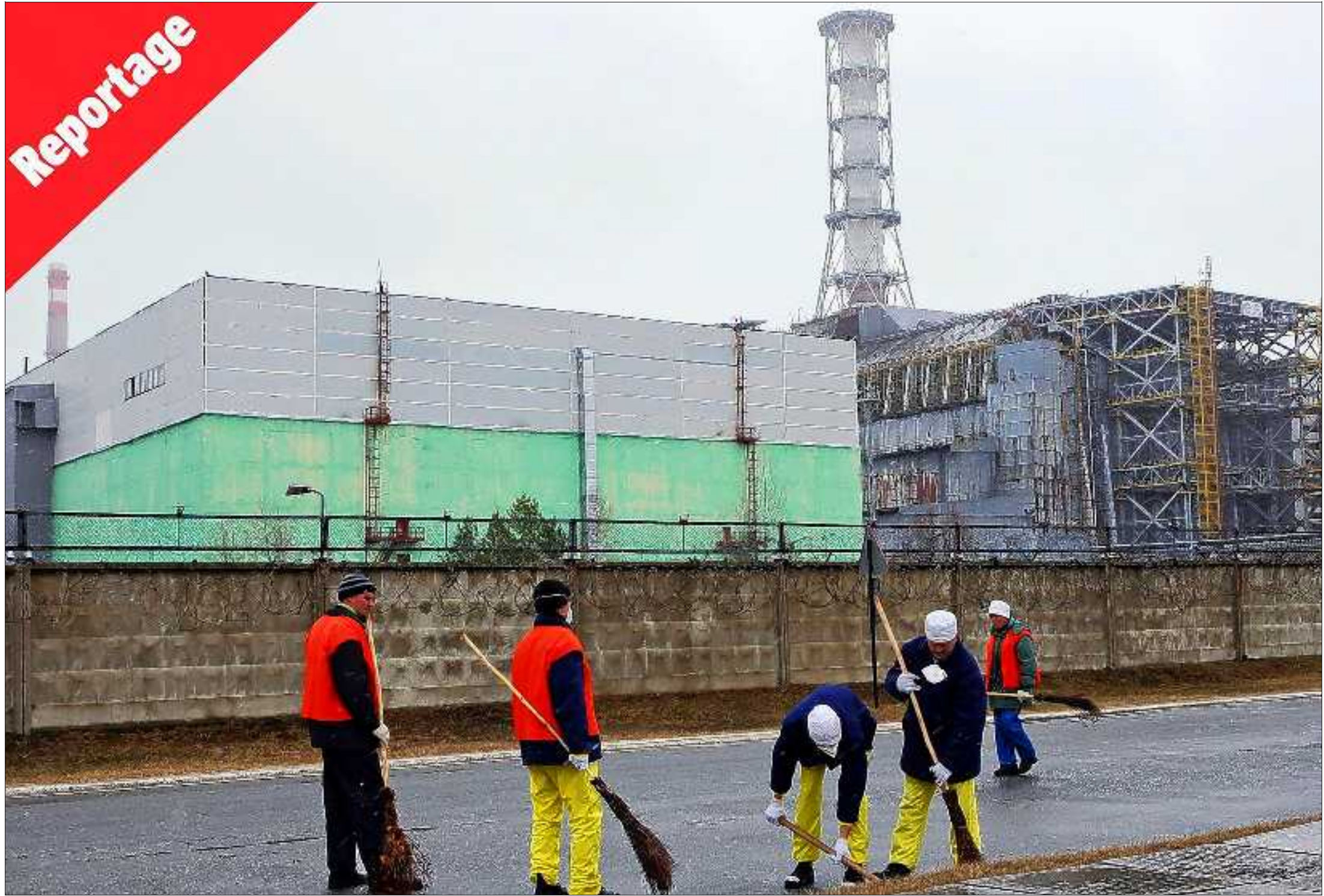
Le réacteur n° 4 de Tchernobyl a été entouré, après la catastrophe, d'un sarcophage qui se fissure. Pour éviter la propagation de poussières radioactives, des ouvriers, avec ou sans masque, nettoient chaque jour les abords avec des balais très rudimentaires. Photo Thierry Gachon
